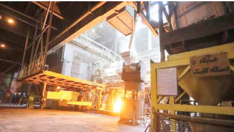
بازسازی کوره شماره ۸ فولاد مبارکه که در جریان جنگ تحمیلی آسیب دید / عکس: تسنیم
