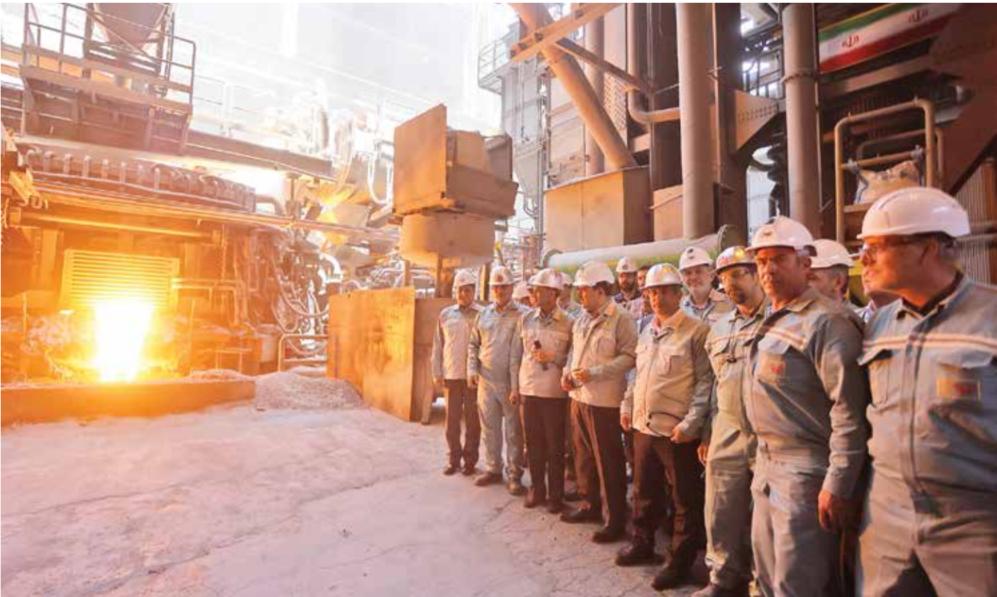
بازسازی کوره شماره ۸ در شرکت فولاد مبارکه ۱
