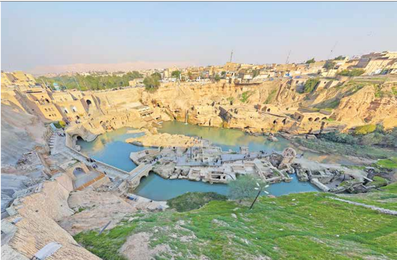
سازه‌های آبی تاریخی شوشتر مجموعه‌ای به‌هم‌پیوسته از پل‌ها، بندها، آسیاب‌ها، آبشارها، کانال‌ها و تونل‌های عظیم هدایت آب هستند که در ارتباط با یکدیگر کار می‌کنند
