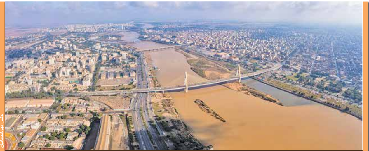
تصویری از پل غدیرپایان کابلی اهواز است. طول آن ۱۰۲ متر و عرض آن ۲۲ متر است. این پل منطقه امامیه و خیابان تخت سلیمان در غرب رود کارون در خیابان زند در شرق این رودخانه متصل می کند
