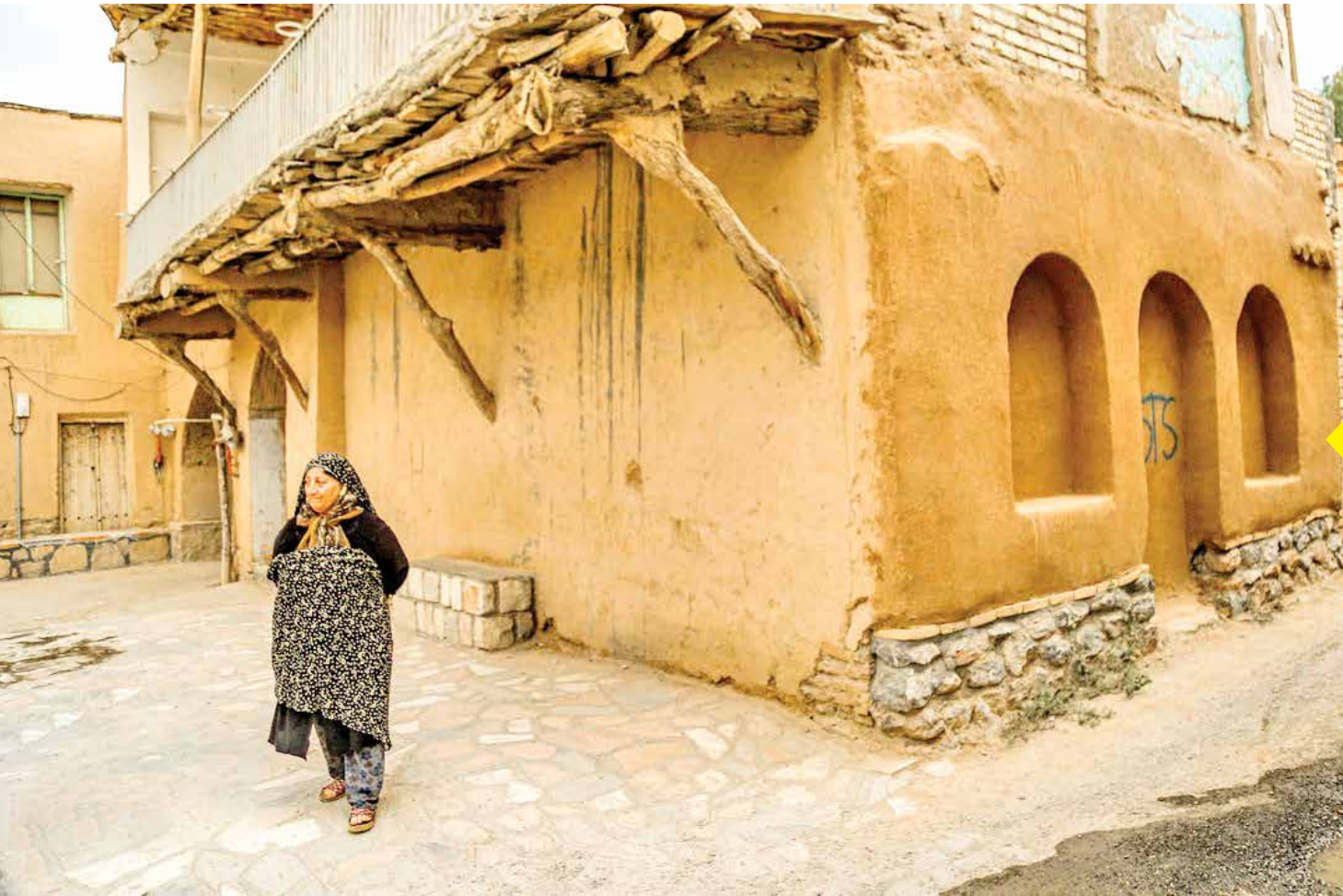
یاسه جای، روستایی در دل شهرستان سامان چهارمحال و بختیاری و در کنار رودخانه زاینده‌رود از قدمتی بیش از ۴۰۰سال، یکی از روستاهای توریستی ایران به شمار می‌رود. این آبادی به دلیل بافت قدیمی و خشت و گلی لقب «روستای بدون کوچه ایران» گرفته است.
