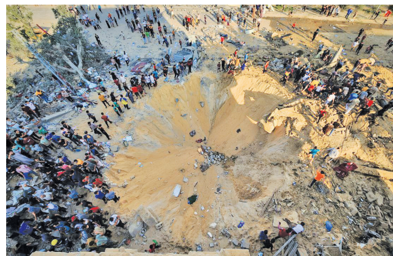
اصابت موشک ارتش صهیونیستی و تخریب یک منزل مسکونی در رفح / عکس: AP
