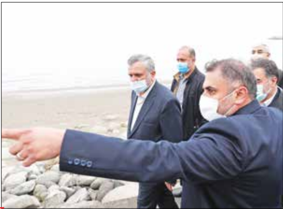
ایران، بازدید معاون اجرایی رئیس‌جمهور، از اجرای عملیات احداث بندر ۲۰۰ روزه
