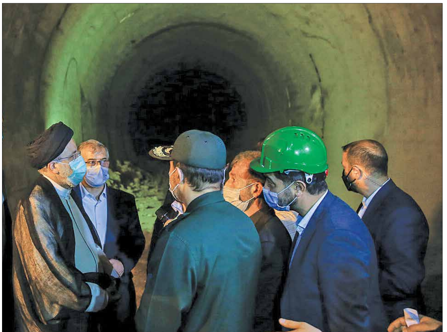
بازدید آیت‌الله رئیسی از کارگاه ساخت خط ۲ قطار شهری کرج / ایرنا
