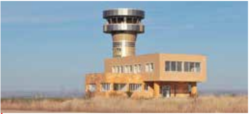
فرودگاه نیمه تمام " کلاله"
