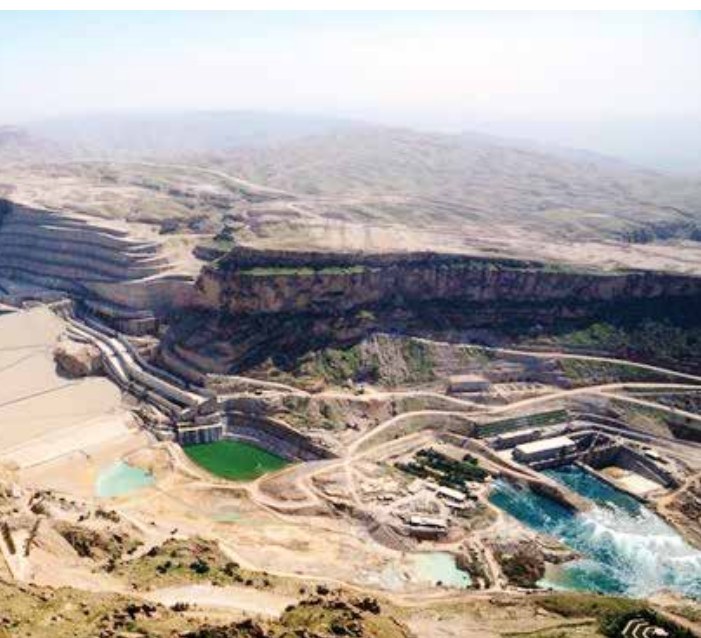
سد گتوند روی سازند نمکی گچساران و چاه‌های فعال نفت ساخته شد در حالی که سازمان محیط‌زیست هیچگاه مجوز ساخت سد گتوند را صادر نکرد
