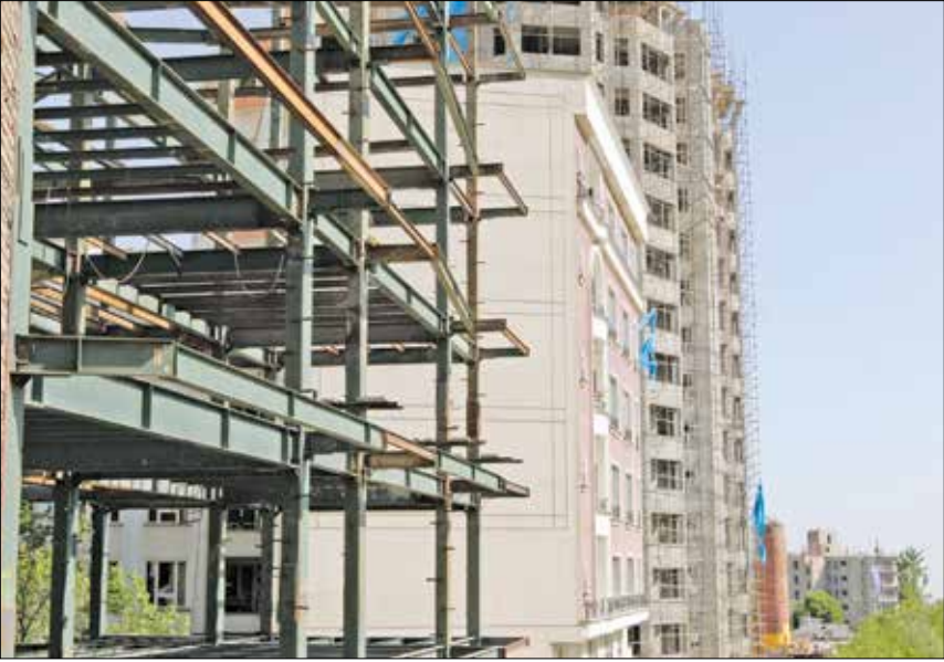
ایستادن در کنار اسکلت فلزی یک ساختمان مسکن در تهران
