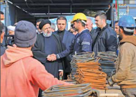
بازدید از پروژه در حال تکمیل تصفیه خانه فاضلاب رباط کریم
