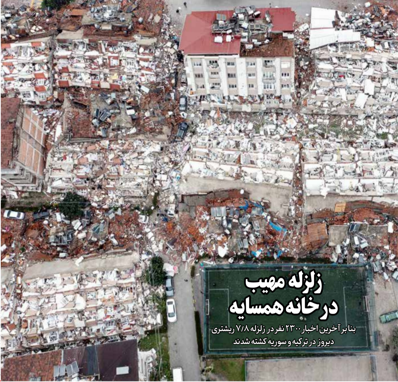
خراب‌های ناشی از زلزله در ترکیه، AP
