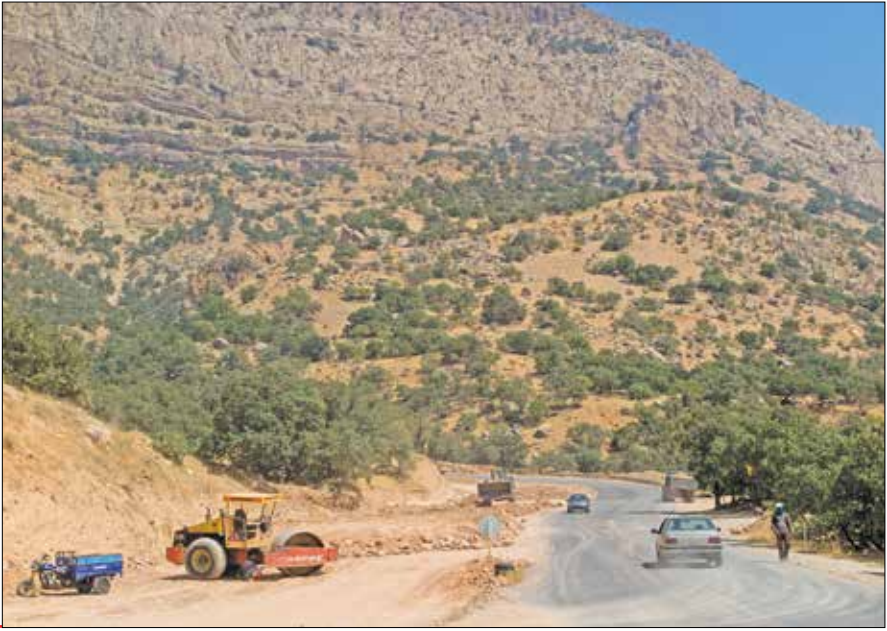
بازسازی راه‌های روستایی در استان آذربایجان شرقی
